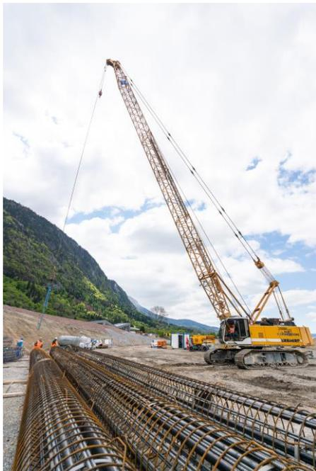
En effet, la réglementation impose d'armer les pieux sur tout leur profil quand il s'agit de pieux de fondation d'ouvrage d'art. Cela se comprend quand on sait que ces ouvrages sont calculés pour avoir une durée de vie de 100 ans. De plus, ce pont se situe dans une zone de sismicité 4, le plus fort niveau existant en France métropolitaine, et est classé en catégorie d'importance III. Ces hypothèses sismiques imposent des sections de ferrailage plus
