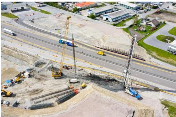
D'une portée de 44 m et d'une largeur de 15 m, le pont de franchissement a été conçu en structure mixte métal-béton. Afin de limiter la gêne des usagers de l'autoroute, le pont a été conçu sans pile centrale. Pour soutenir l'ensemble, 2 culées ont été assises sur 24 pieux de fondation, 12 par culée. Forés à la tarière creuse en diamètre 1 220 mm et armés toute hauteur sur une profondeur de 30 m.
